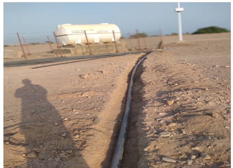
Déroulement des travaux de raccordement à l'eau © Photo : IOM Djibouti 2021
